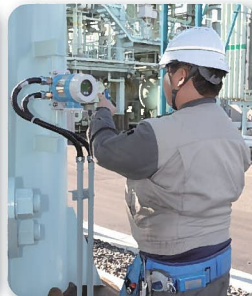
現場バトラーによる点検
